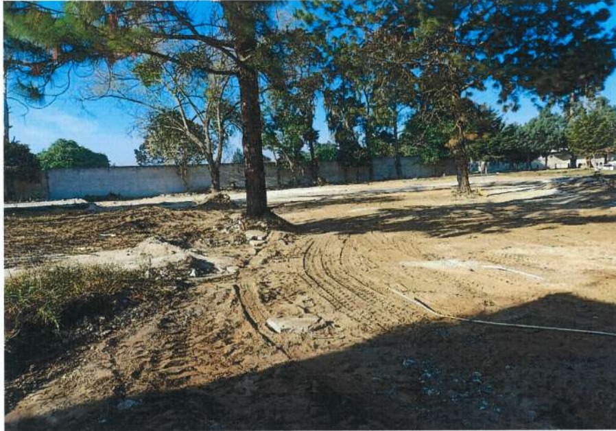
PREPARACION DE PLATAFORMAS
